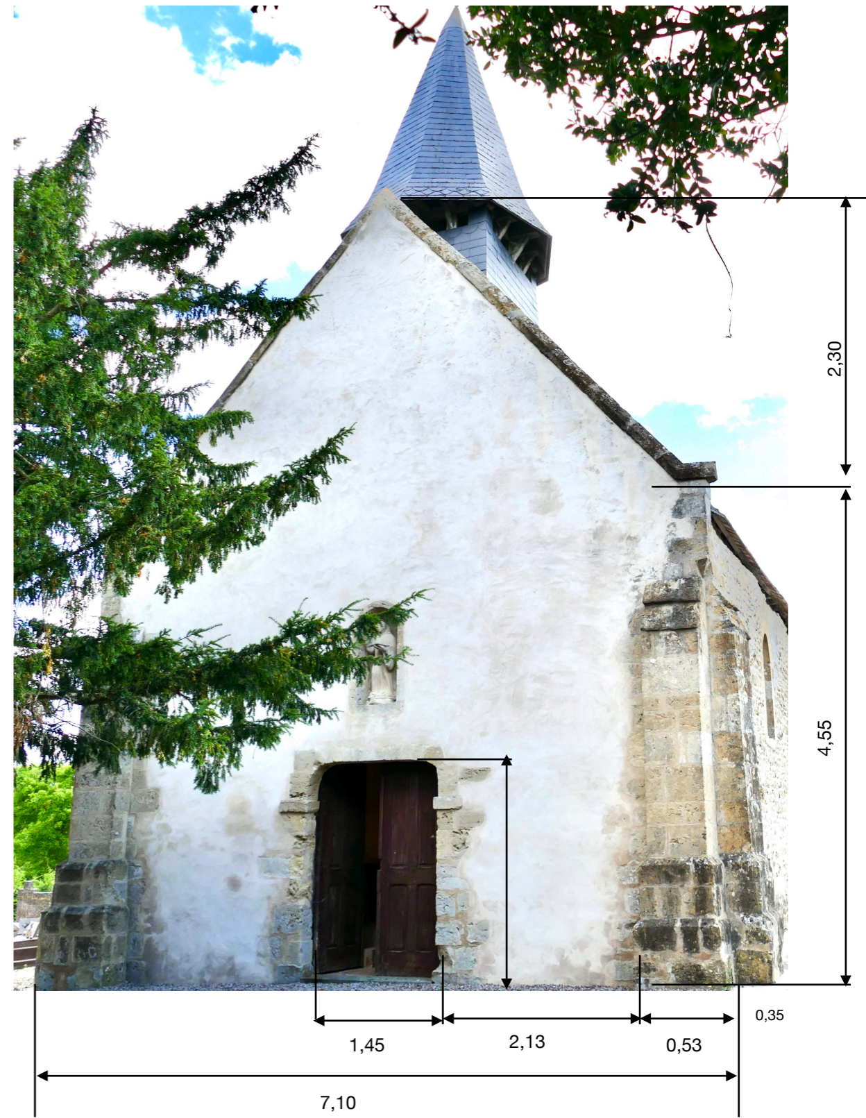
Entrée principale - façade Ouest
